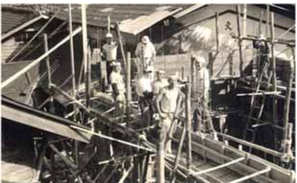
旧精米所の建築
