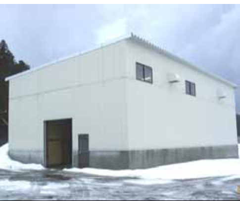
壇貯蔵用冷蔵倉庫
